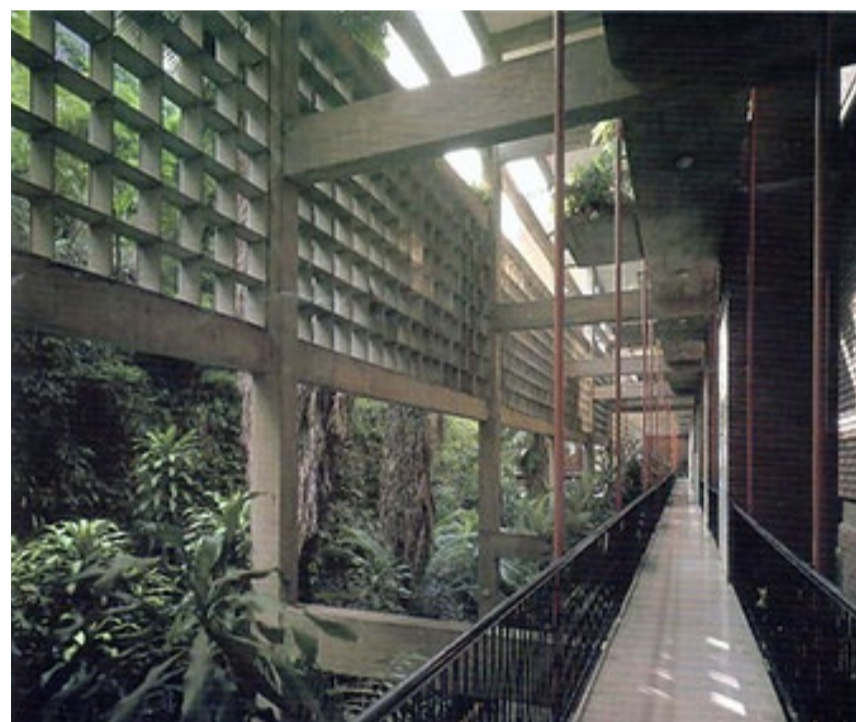
PASILLOS INTERNOS EDIFICIO ALTOLAR DE JIMMY ALCOCK / ©PAOLO GASPARINI
